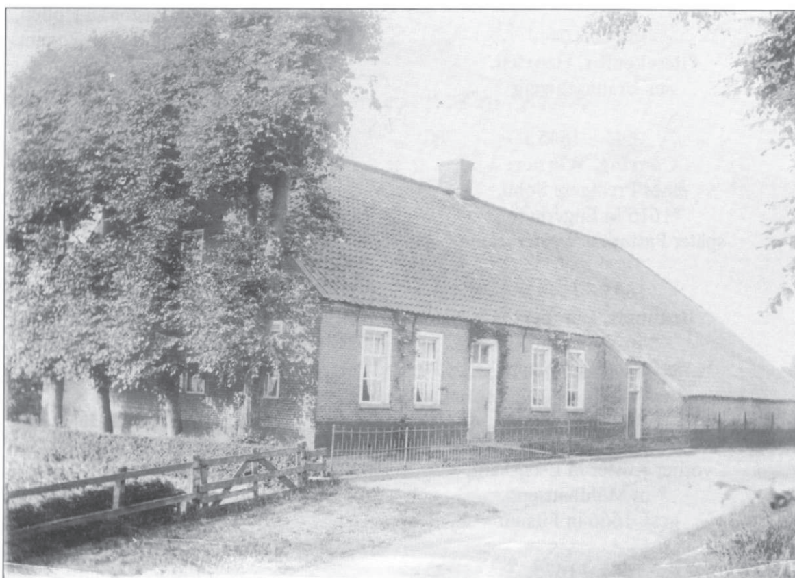
Das alte Filsumer Pfarrhaus, nach einem Brand 1914 abgerissen. Vor dem Westgiebel standen damals noch vier Linden; heute nur noch die beiden äußeren!
